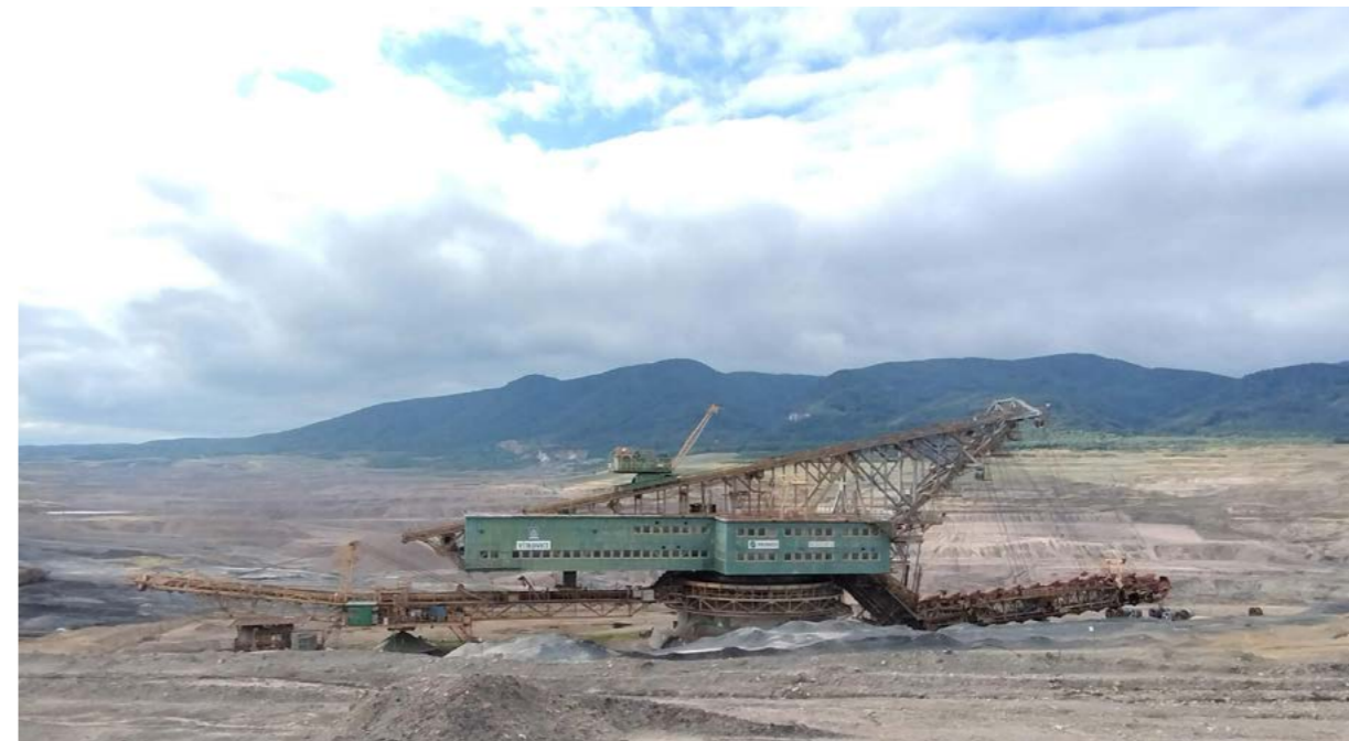
Obr. 151: Rypadlo RK5000 ve velkolomu ČSA v roce 2023 (zdroj: archiv autora)
