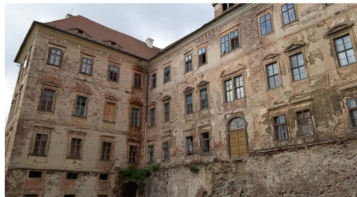
Obr. 128: Pohled na východní fasádu zámku v r. 2022 (zdroj: archiv autora)
