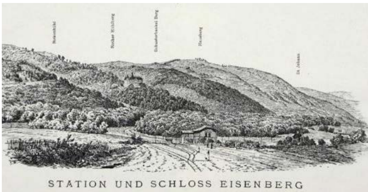
Obr. 36: Železniční stanice a zámek Jezeří, kresba F. Wachsmann (zdroj: neznámý)
