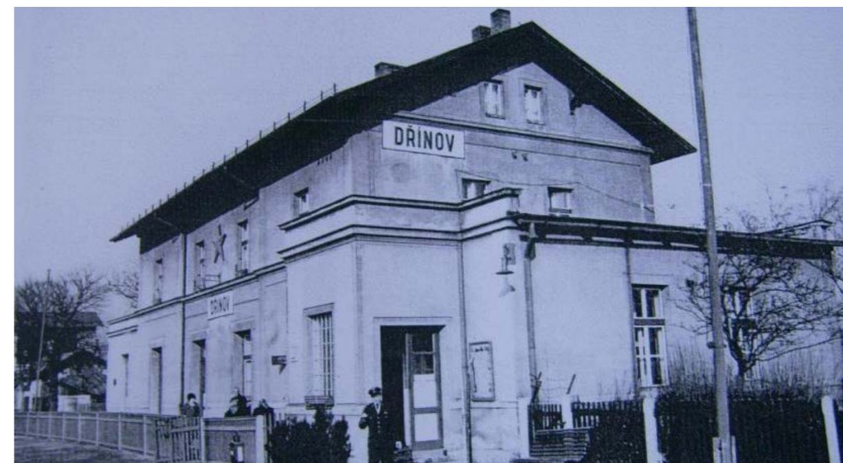
Obr. 86: Nádraží v Dřínově - 60. léta 20. století (zdroj: zanikleobce.cz)
