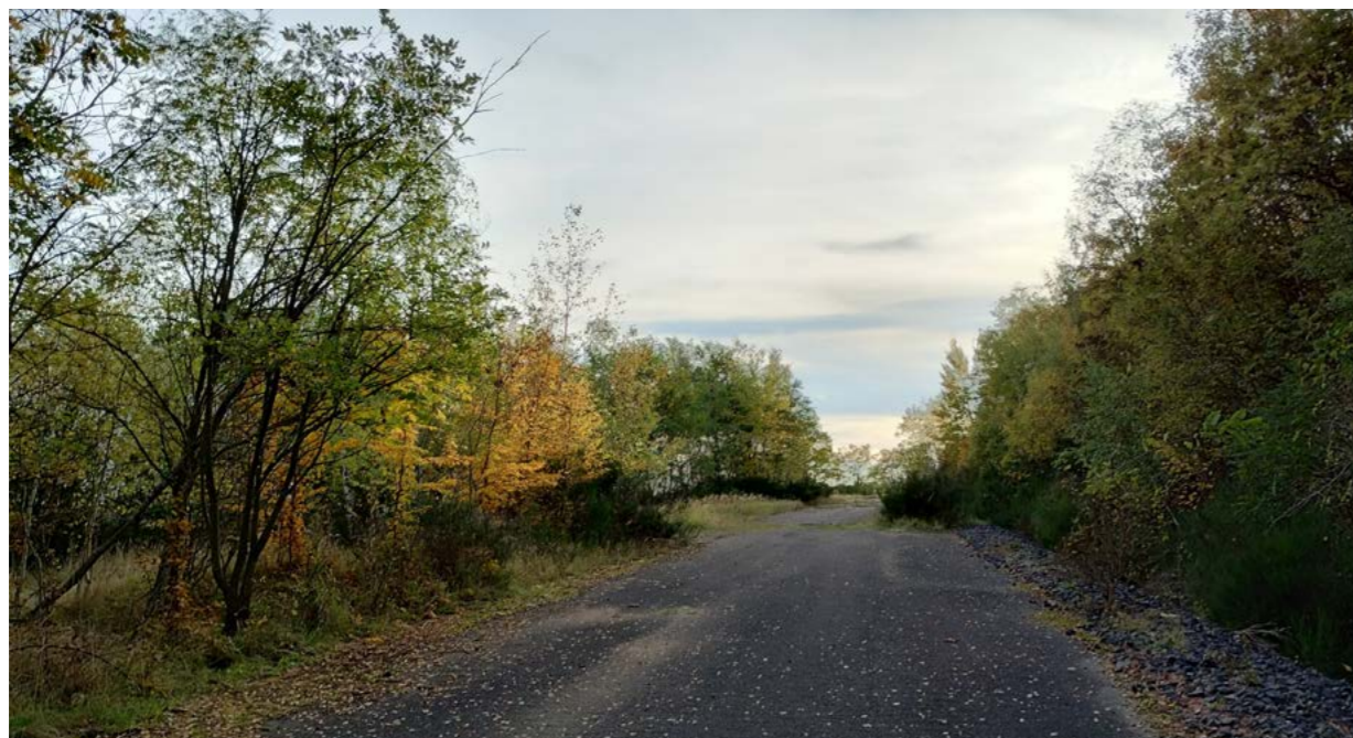
Obr. 145: Východní konec býv. Chomutovské silnice pod zámekem v roce 2023 (zdroj: archiv autora)
