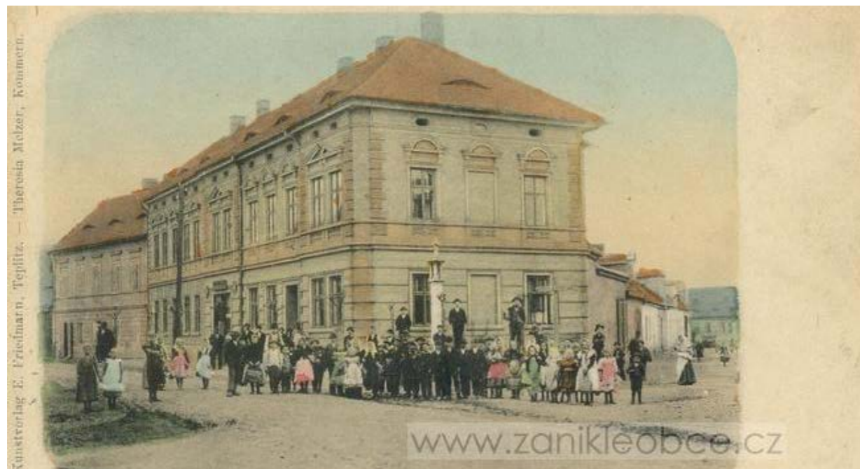
Obr. 71: Škola v Komořanech - nedatováno (zdroj: zanikleobce.cz)
