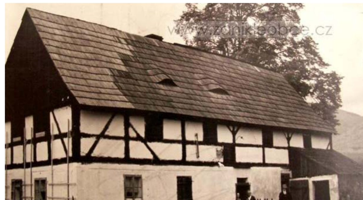
Obr. 102: Dům č. p. 30 - nedatováno (zdroj: zanikleobce.cz)
