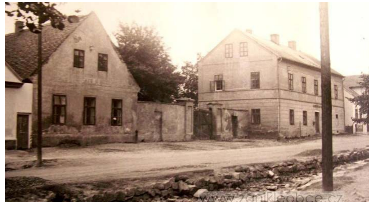
Obr. 105: Dům č. p. 47 - nedatováno (zdroj: zanikleobce.cz)
