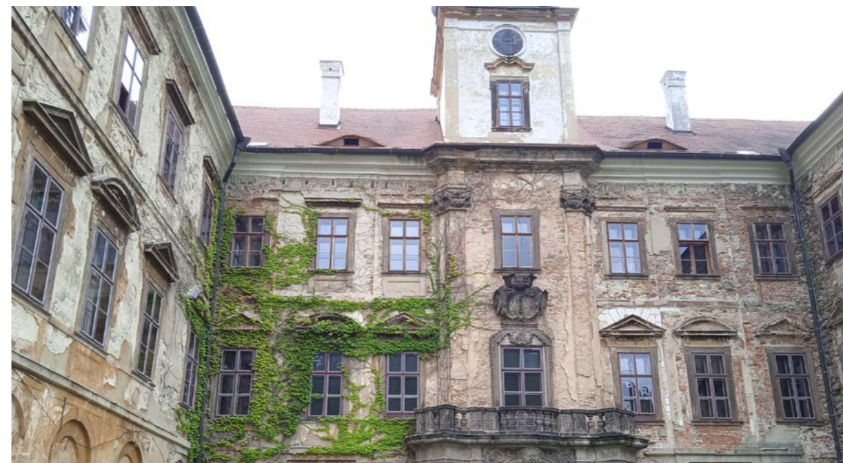
Obr. 127: Pohled na západní fasádu zámku v r. 2022 (zdroj: archiv autora)
