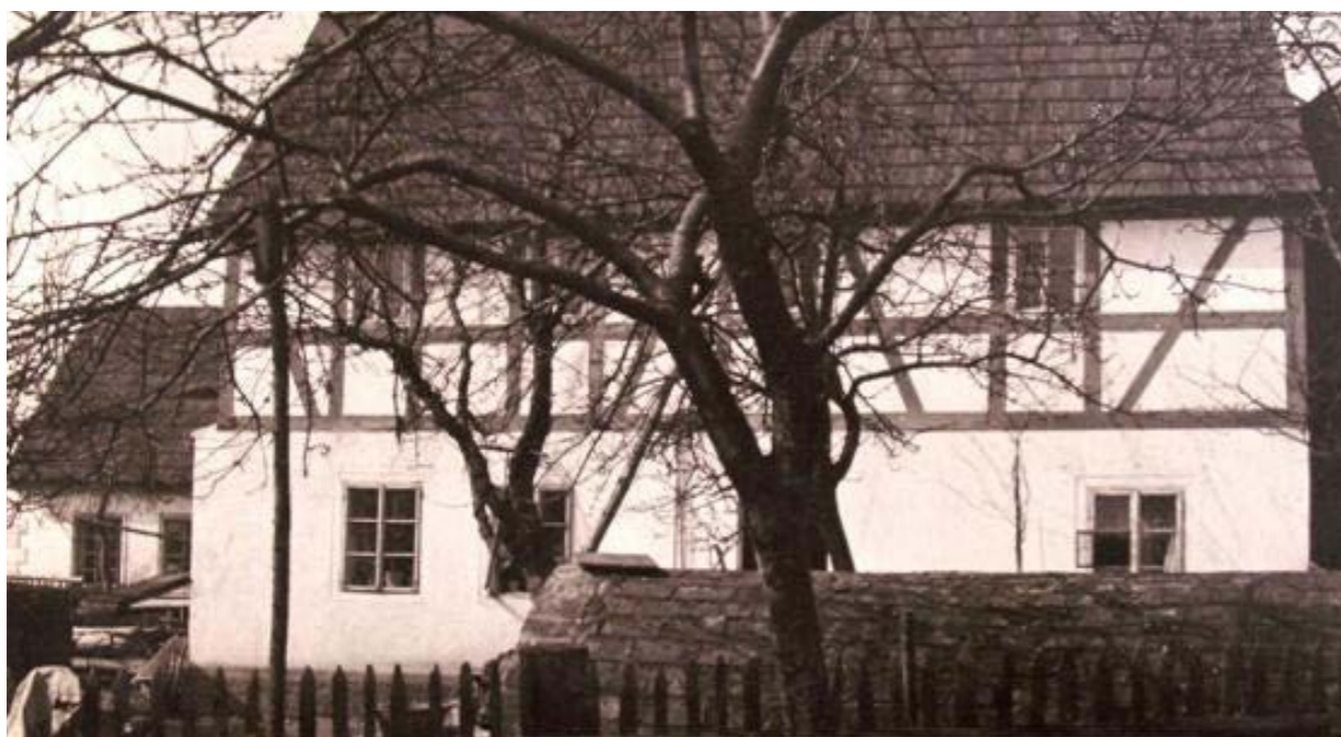
Obr. 100: Dům č. p. 54 - nedatováno (zdroj: zanikleobce.cz)
