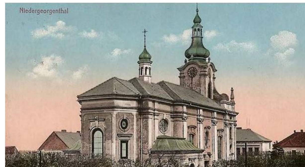
Obr. 113: Kostel sv. Mikuláše - nedatováno (zdroj: zanikleobce.cz)
