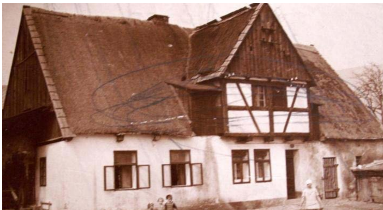
Obr. 99: Dům č. p. 5 - nedatováno (zdroj: zanikleobce.cz)
