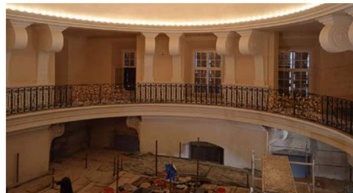
Obr. 19 – Divadelní sál v závěru probíhající obnovy (červenec 2022)
