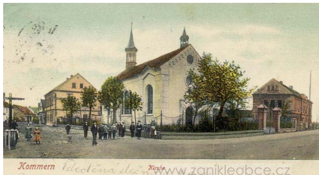
Obr. 72: Kostel v Komořanech v roce 1905 (zdroj: zanikleobce.cz)
