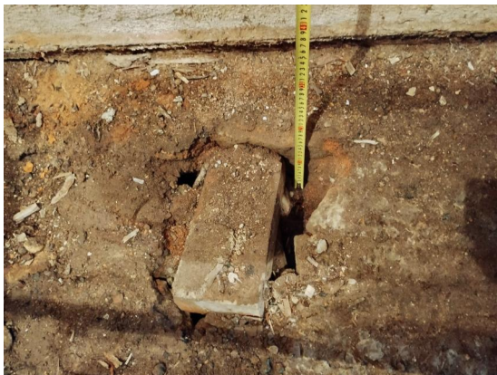
Průzkumná sonda podlahy - SP3
