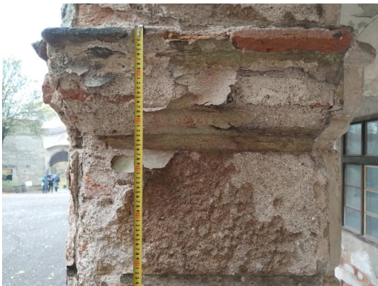
Průzkumná sonda omítky - SO4
