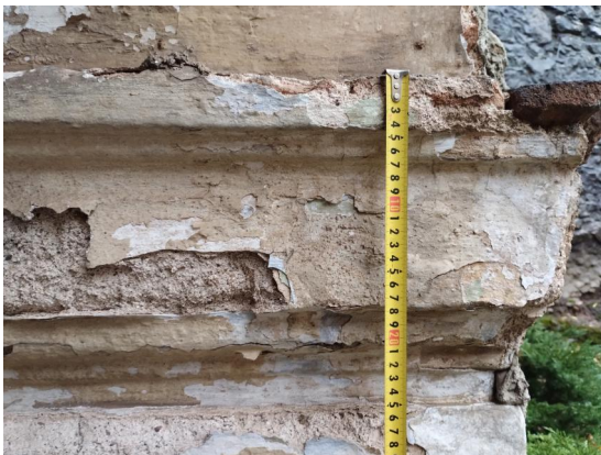
Průzkumná sonda omítky - SO1
