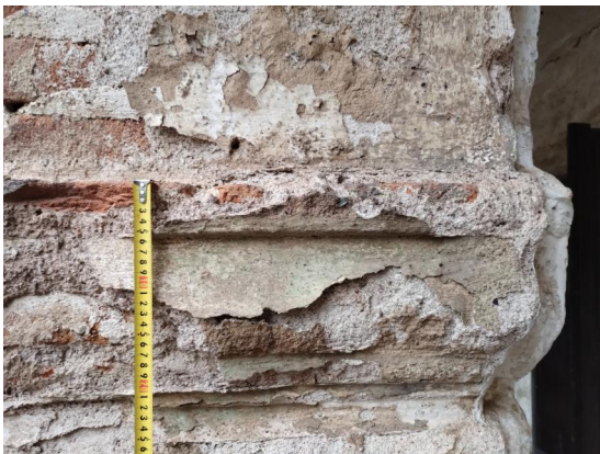
Průzkumná sonda omítky - SO3
