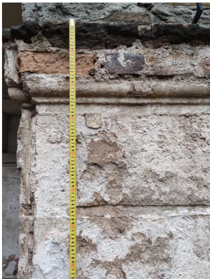
Průzkumná sonda omítky - SO6
