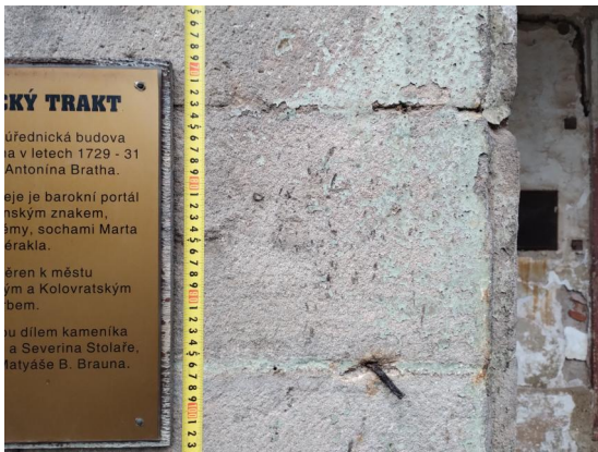
Průzkumná sonda omítky - SO6
