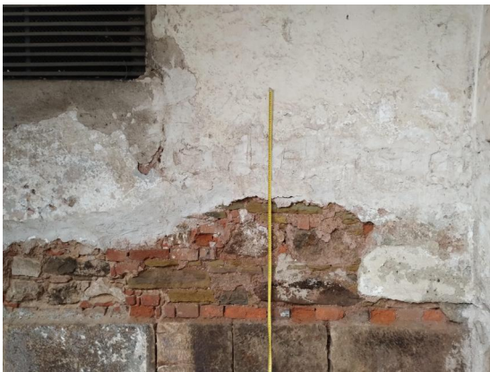
Průzkumná sonda omítky - SO7
